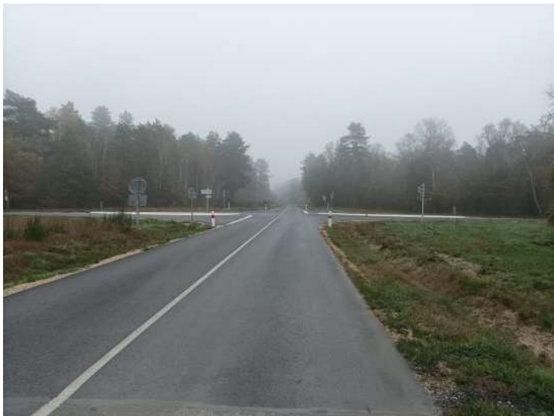
Le carrefour après sécurisation, vu de la RD 75
